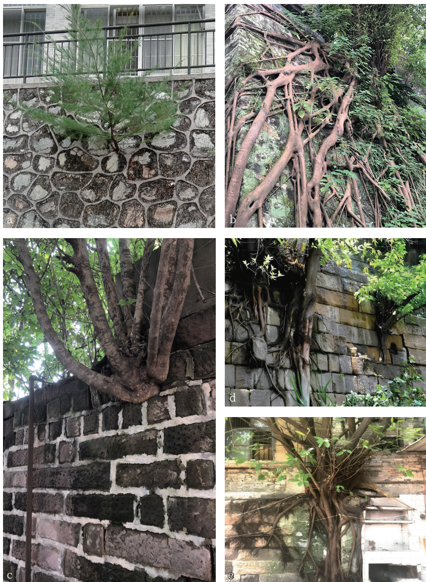
图1 5座石砌挡土墙附生树木
