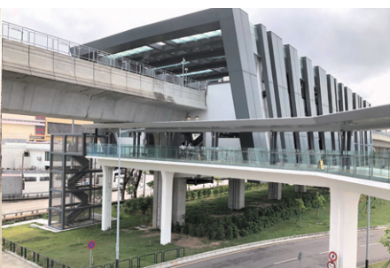
b. 澳门仔客运码头轻轨站桥底未充分利用的消极空间
