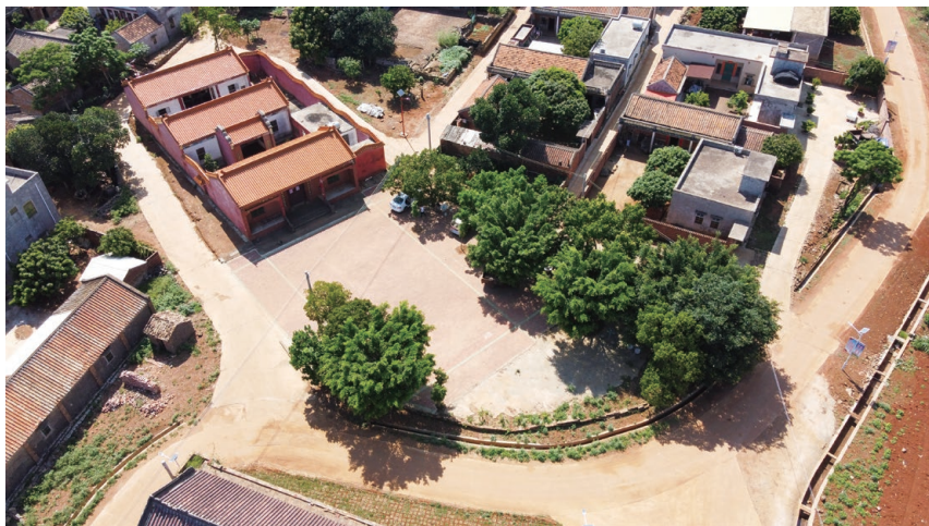
图4 村祠广场建设实景
