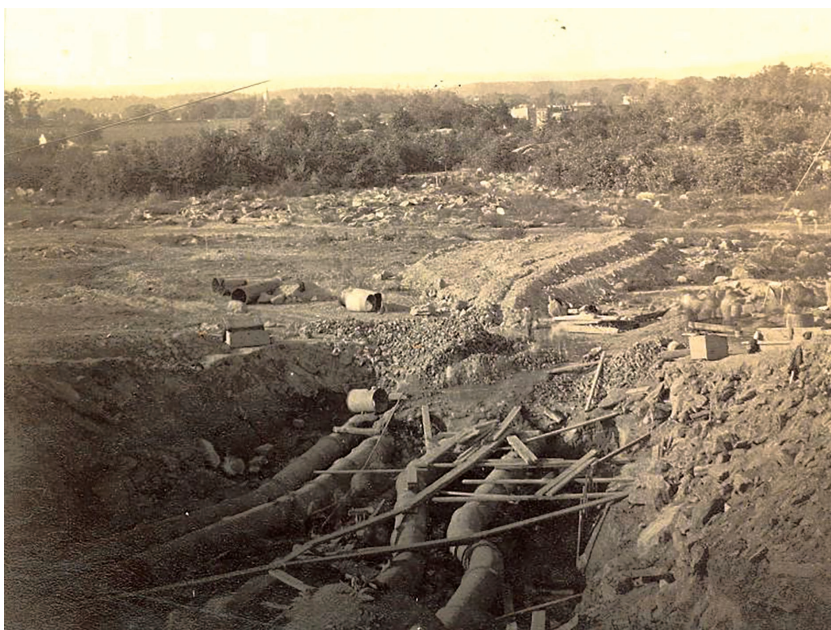
图3 中央公园修建时铺设的水管
