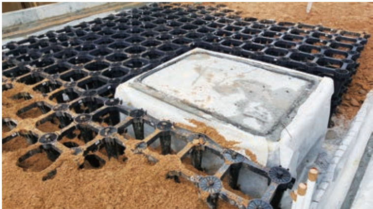
图3 塑料支架支撑人行道地砖
