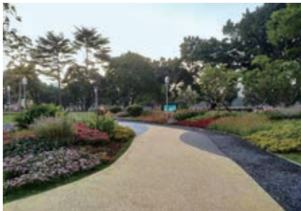
图6 透水混凝土铺装
